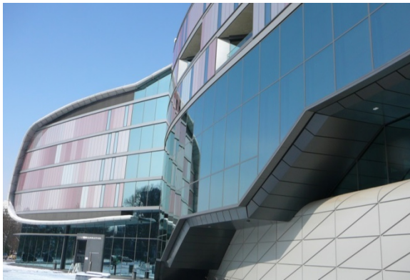
Erweiterungsbau der Deutschen Nationalbibliothek
